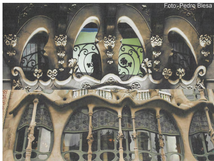
Ventanas de la Madrileña superpuestas a las del primer piso del edificio de la casa Batlló de Gaudí.
